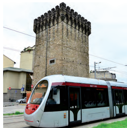
La Torre della Serpe adesso “di guardia” alla moderna tramvia - foto: Mauro Sani
