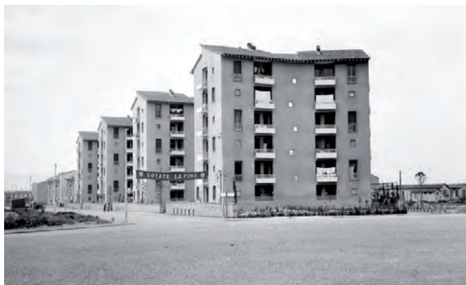
1956. Palazzi in viale delle Magnolie nel quartiere dell'Isolotto Foto Giulio Torrini
