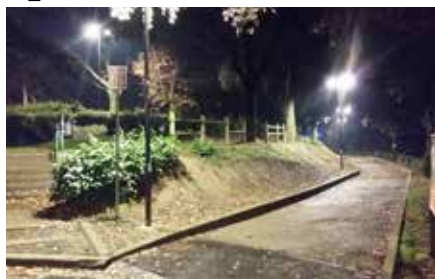
La nuove luci della Montagnola La sicurezza passa anche dalla riqualificazione urbana delle periferie. Uno sforzo che si concretizza ad esempio con la sostituzione dei vecchi corpi illuminanti e l'installazione di nuovi.
